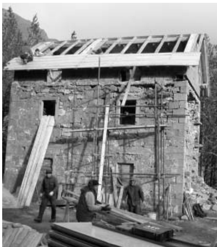
"Lavorando sul tetto del rifugio Mercatello"
