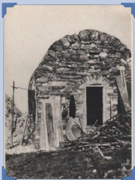
Il rifugio Pania ancora in costruzione (tarda primavera 1924)
